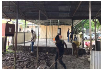
Construcción de una sala de espera con el apoyo de la comunidad luego de obtener comentarios en torno a los cuadros sinópticos
