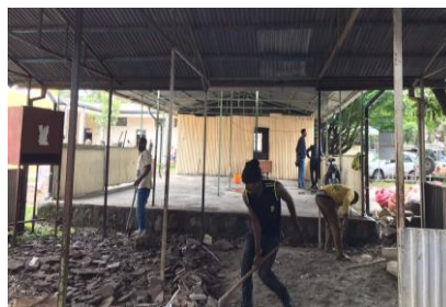
Sala de espera sendo construída com o apoio da Comunidade após o feedback do cartão de pontuação
